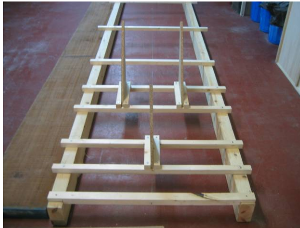
Colocación de soportes de sección
