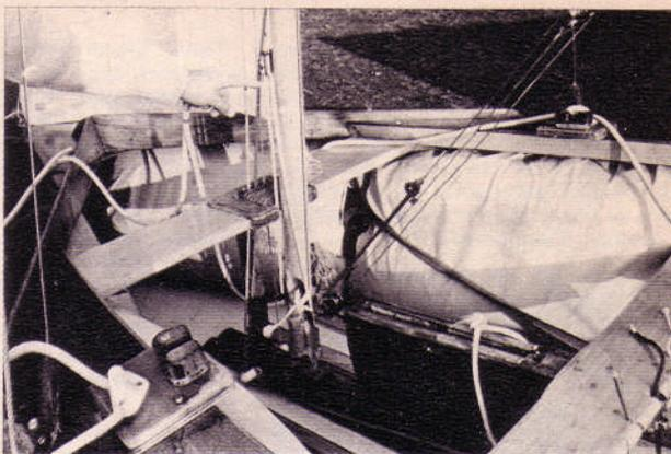
Au bout du doigt, le palan de drisse de foc à trois brins ; à droite, le banc central et ses encoches pour bloquer les bouts de manœuvre.
