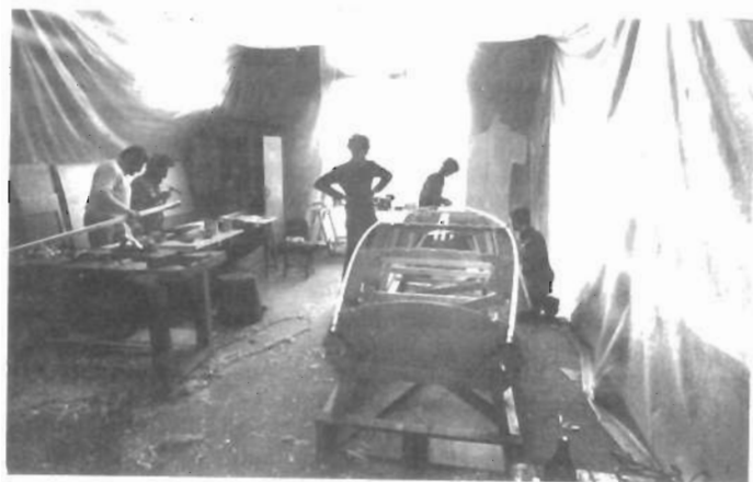
L'installation du chantier sous la tente
