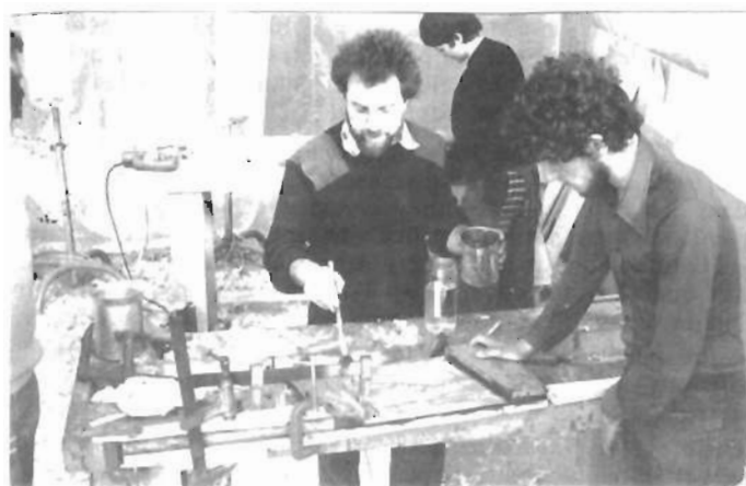
L'intérieur du puits est plastifié avant assemblage
